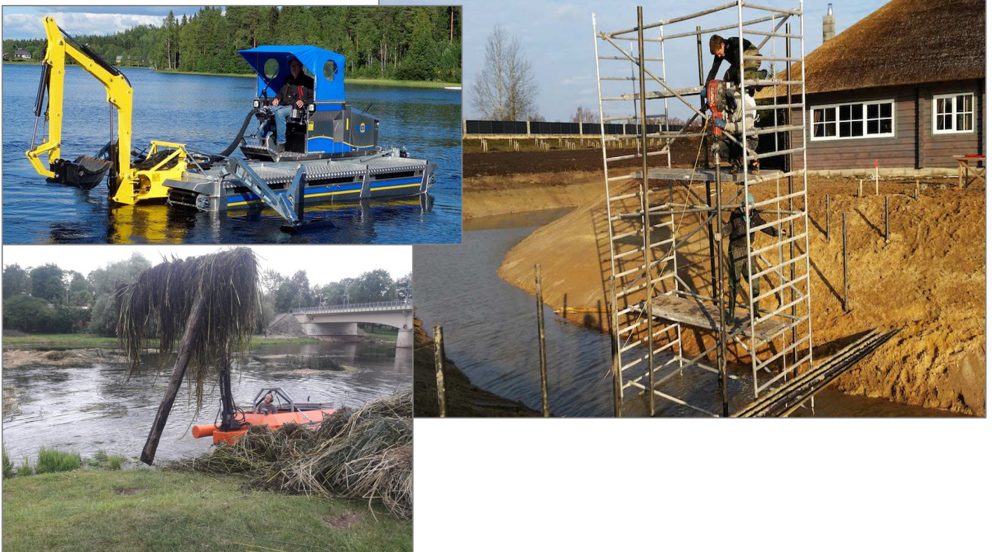
8 pav. Polius į upės dugną iš pradžių įsmeigiamas amfibinio kombaino manipulatoriumi, vėliau nuo pastolių kalamas vibrokaltu (Nuotr. iš www.weedcutter.com ; www.pakranciuprieziura.lt ; www.moletuaplinka.lt )
