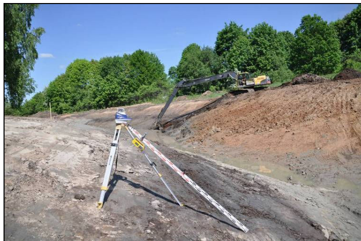
7 pav. Vokės 2-ajame ruože akmenų metinį geriausiai montuoti ant kranto stovinčiu ilgastreliu ekskavatoriumi (A. Balevičiaus nuotr.)
